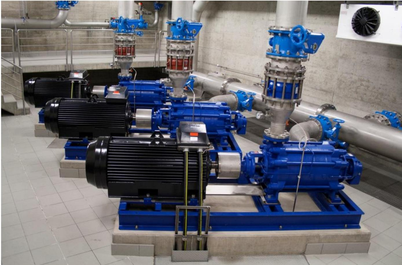
Clapet anti-retour d'eau à la sortie des pompes afin d'éviter le refoulement
