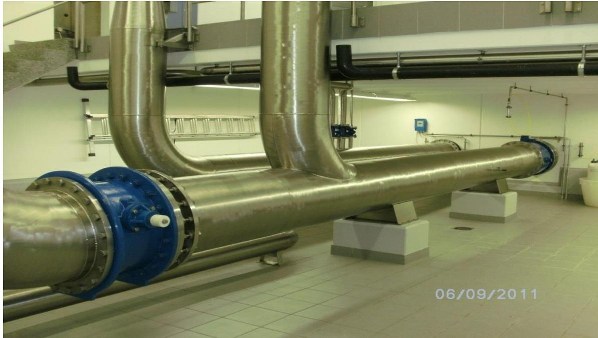
Clapet anti-retour pour assurer un cheminement correct de l'eau dans les cuves
