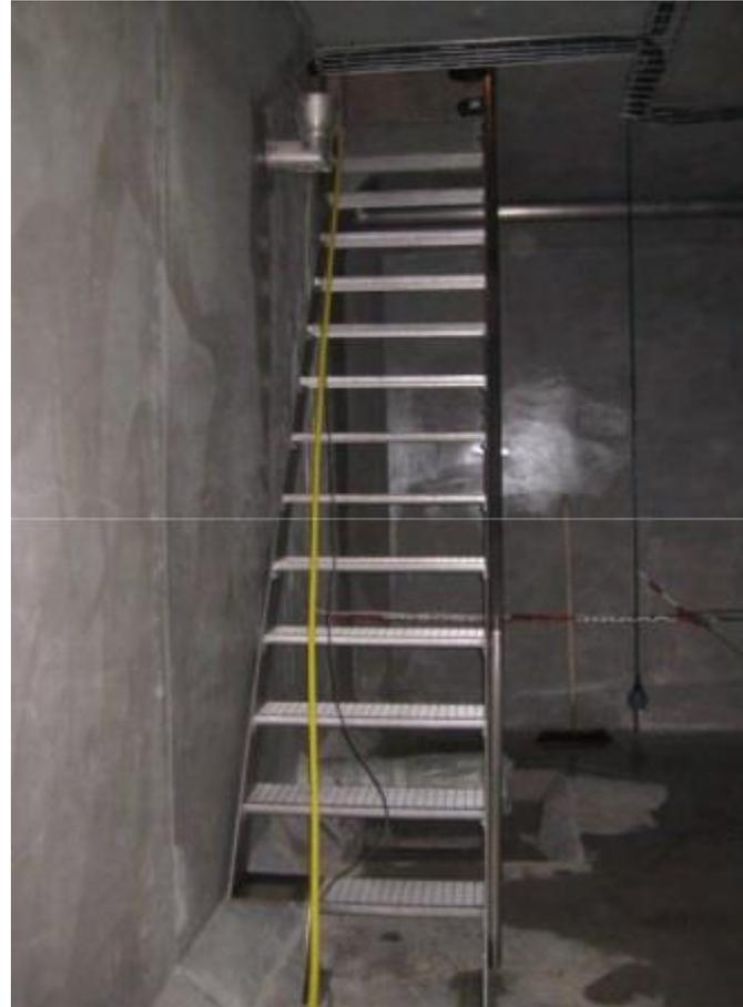
Accès: avant par échelle, remplacé par escalier (facilité, sécurité)
